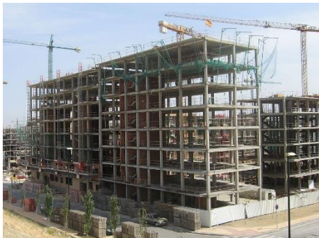
Abbildung 8: Gemeinshaftliche Teile – Die statischen Elemente eines Gebäudes (Bauteile) wie Stützen, Boden, Decke, Dach 6
