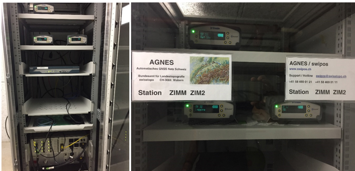
Figure 2-9 : récepteurs GNSS AGNES (baie/rack) et vue de détail des récepteurs GNSS ZIMM et ZIM2
