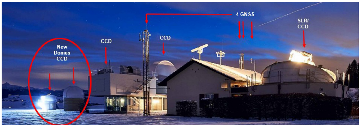
Figure 2-5 : géostation de Zimmerwald ; ancienne coupole astronomique, mâts GNSS (au milieu), coupole SLR (à droite) et nouvelles coupoles CCD à l'arrière-plan.
