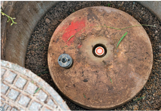
Figure 2: point fixe planimétrique type en plaine. La calotte (à gauche) est dévissée et une cible de centrage est montée sur la cheville mise à nu. Dès que la possibilité se présentait (ce qui n'était visiblement pas le cas ici), les points étaient directe- ment scellés dans la roche, sans recourir à un socle en béton.
