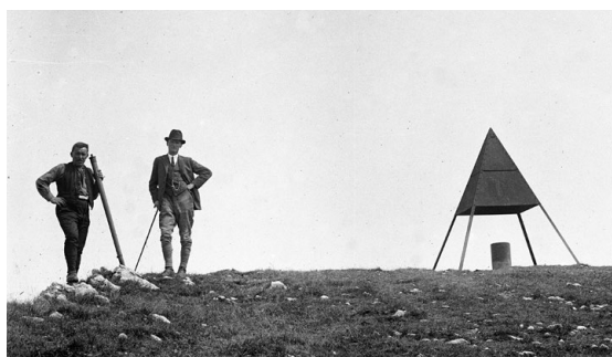
Figure 1: topographes sur le Chasseral, 1921. La «pyramide» signale le point de triangulation (swisstopo, collection photographique, n° d'inventaire 000-389-722).
