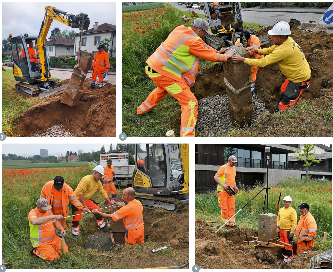
Figures 3 et 4: une excavatrice soulève puis repose la borne pesant près de 400 kg – il faut s’y mettre à trois pour dresser la borne (© P. Reimann) Figures 5 et 6: contrôle avec le repérage et contrôle final par GNSS. La satisfaction du devoir accompli se lit sur les visages des participants. (© P. Reimann)
