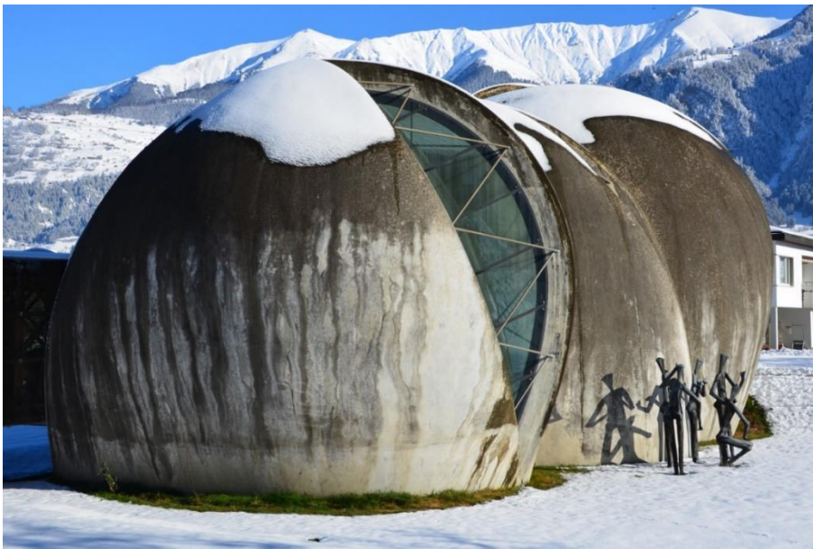
Figure 8 Construction en coque de l'église Steinkirche à Cazis (source: graubuenden.ch)
