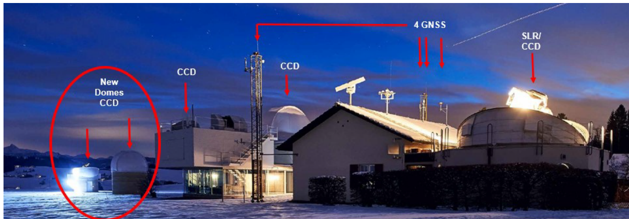
Abbildung 2-5: Geostation Zimmerwald. Alte astronomische Kuppel, GNSS-Masten (Mitte), SLR-Kuppel (rechts) und neue CCD-Kuppeln im Hintergrund
