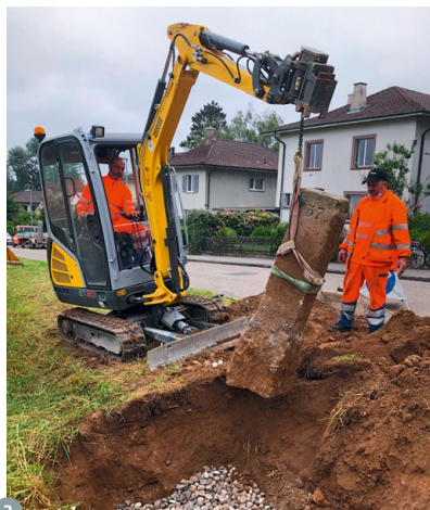
Abbildungen 3 und 4: Ein Bagger hebt und setzt den 400 kg schweren Stein zurück – das Richten des Steins geschieht zu Dritt. (© P. Reimann)
